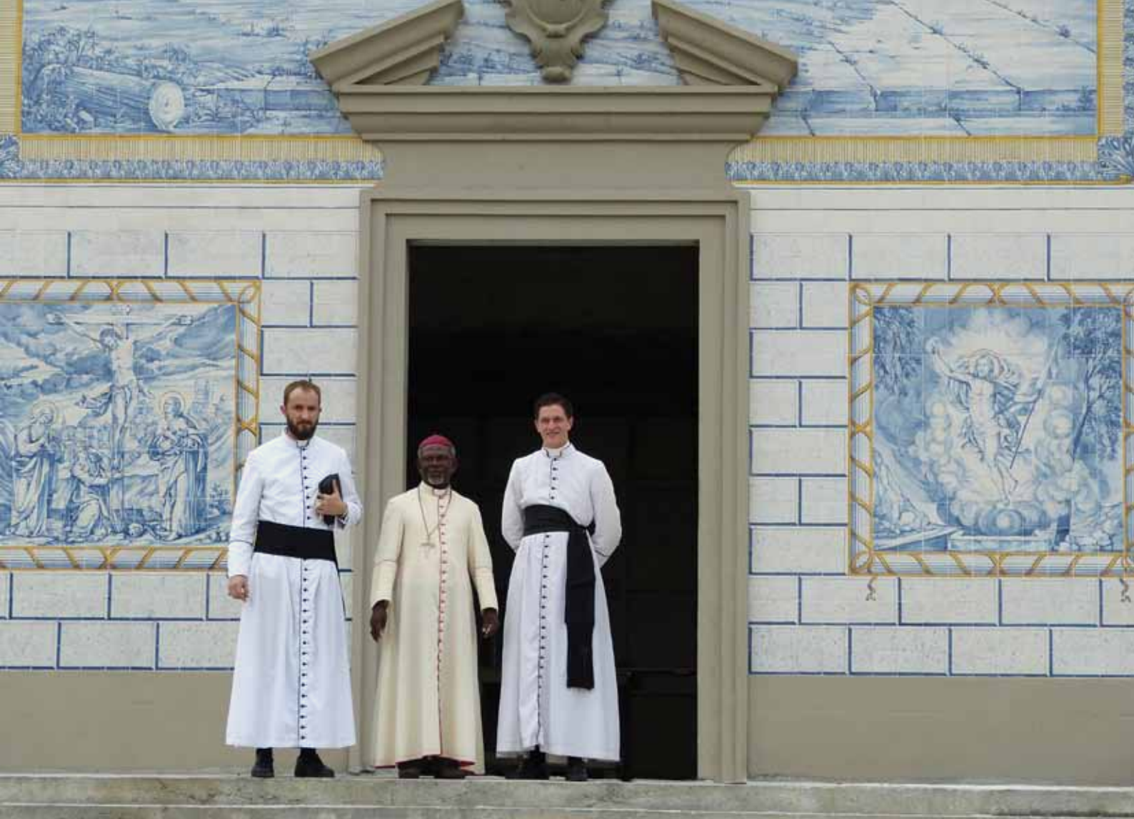
S.Exc.R. Mgr Mvé Engone, archevêque de Libreville, visitant les travaux de l'église du Christ Roi en janvier 2015.
