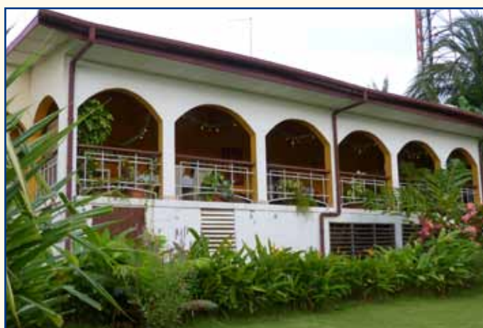
... et ci-dessus la même maison dix ans après, entièrement rénovée et rebaptisée maison des chanoines. Trois grandes pièces ont été aménagées, libérant autant d'espace dans la maison principale pour les activités du patronage.
